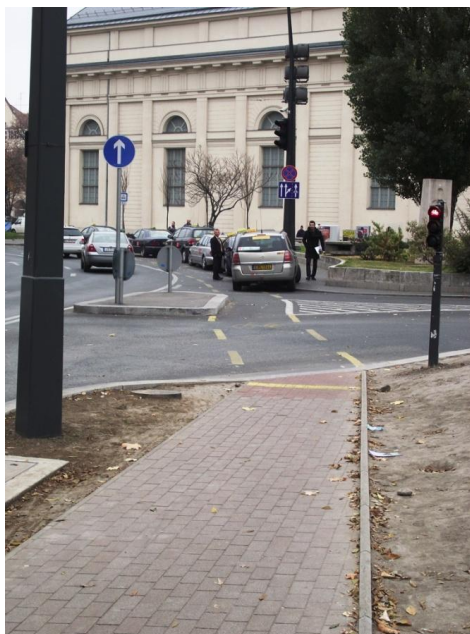
41. ábra Kerékpársáv kiemelt szegéllyel kialakított terelősziget mellett
