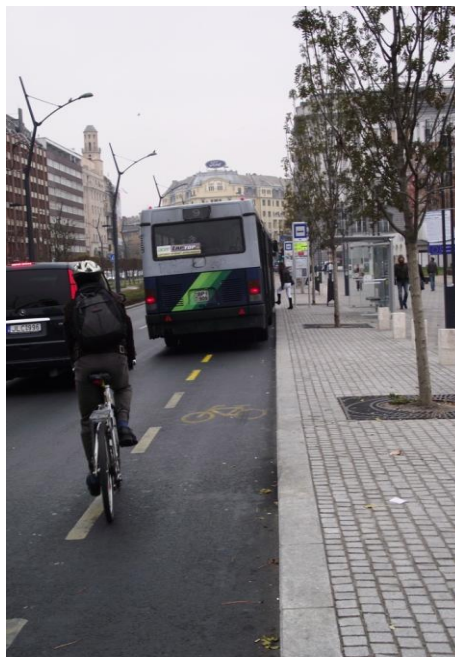
43. ábra Buszmegállón átvezetett kerékpársáv
