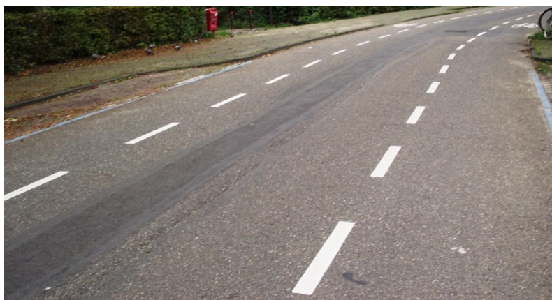
23. ábra Nyitott kerékpársáv kialakítása
